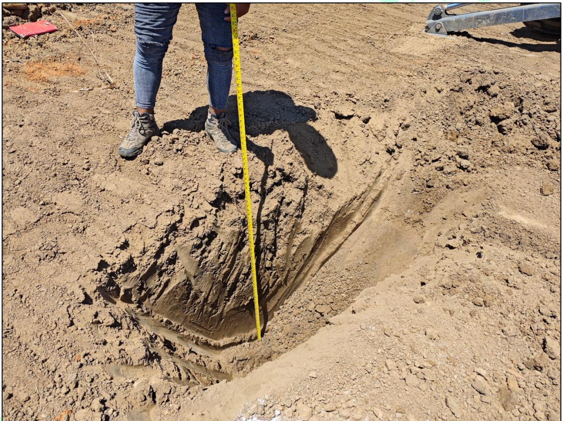
Imagen 19. Exploración Apique 11 terminada y medición de perfil estratigráfico.
