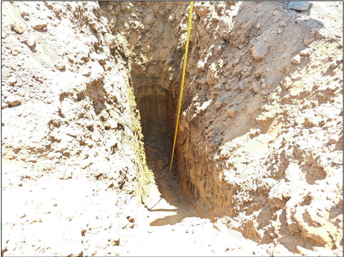
Imagen 10. Apique 2 terminado y medición de perfil estratigráfico.
